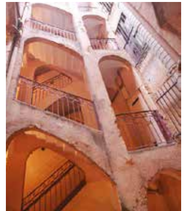
Cage d'escalier de la résidence
