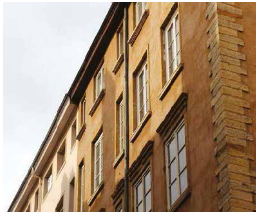
Façade de l'immeuble
